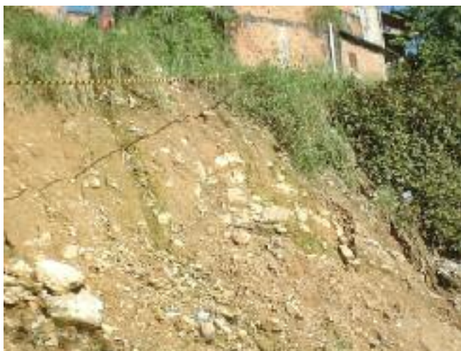
Solo residual de rocha metamórfica, exposto após ruptura de encosta em Salvador, Bahia
