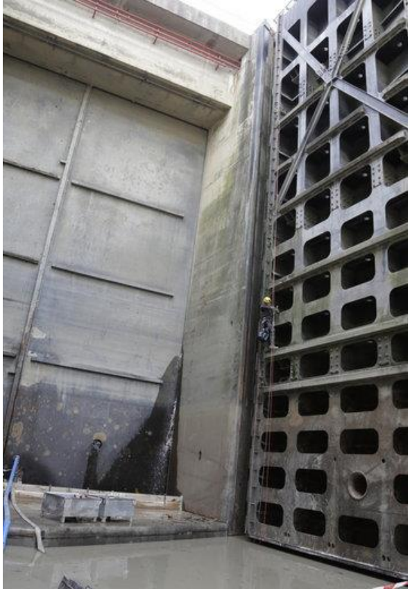
Dans l'écluse close par les batardeaux, un cordiste monte et descend sur une vingtaine de mètres de hauteur pour contrôler les joints des portes.
