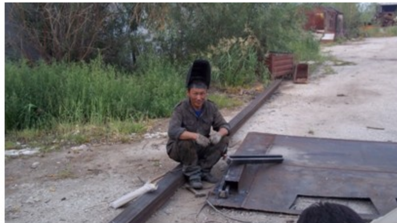
Сварочные работы теплообменника
