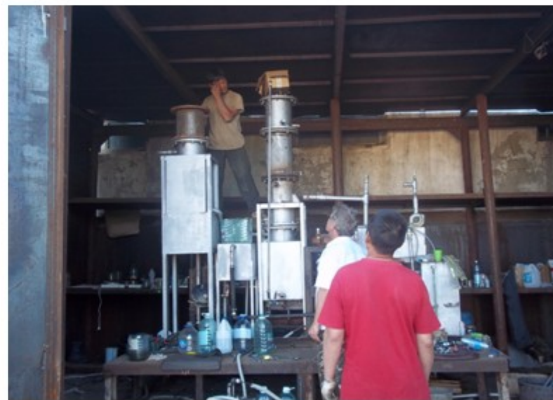
Идет сборка установки
