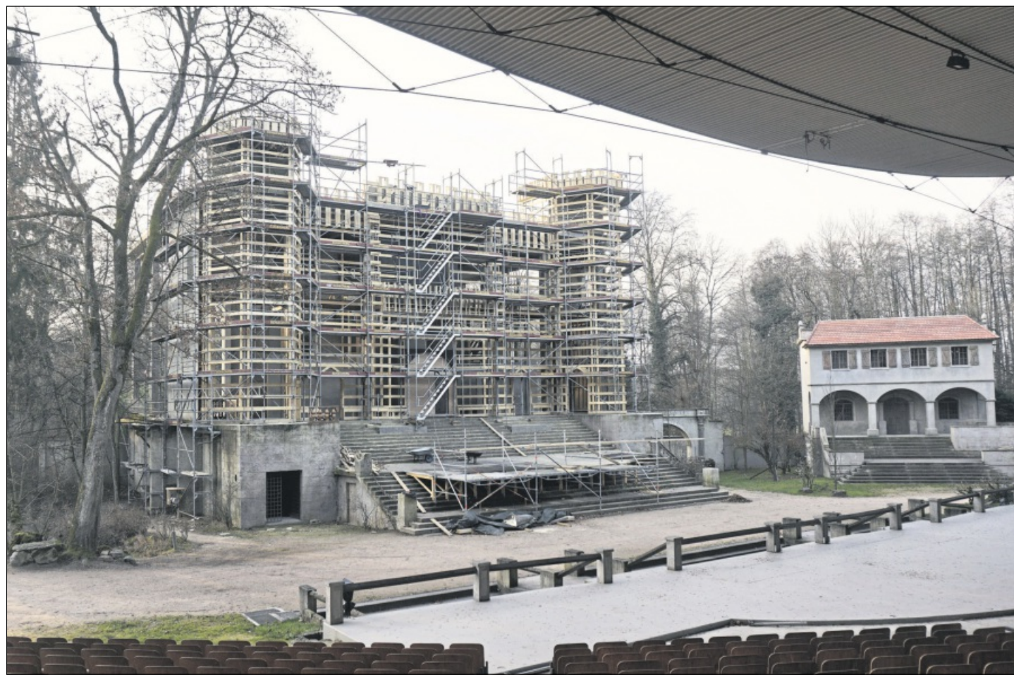
BAUSTELLE AN DER MITTELALTERLICHEN BURG: Bis zum April soll auf dem Tellplatz der Mittelbau der abgerissenen Kathedrale als Burg wieder aufgebaut werden, die im „Luther“-Stück eine wichtige Rolle spielt. Foto: Collet
