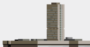
Telli-Hochhaus, Aarau 1973, 75 m
