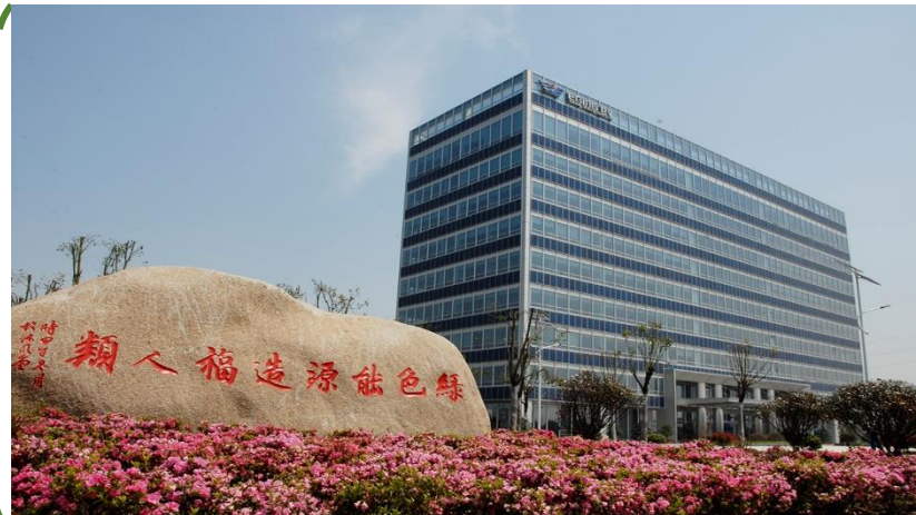
2MW EGing budynek i dach EG-250P-60
