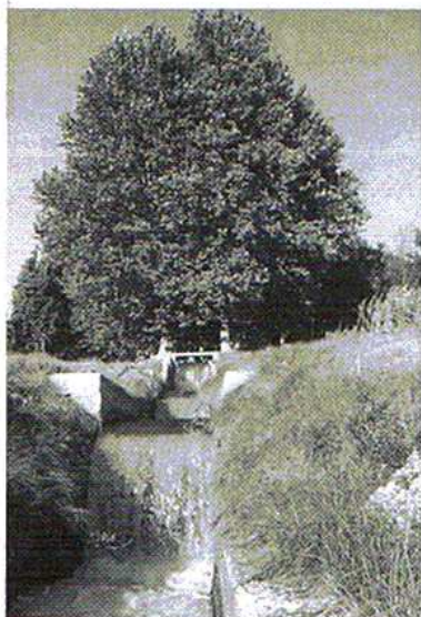
A la fotografia de grup, membres del CAM al poblet d'Àreu. Damunt d'aquestes ratlles, l'indret anomenat Nou Salts.
