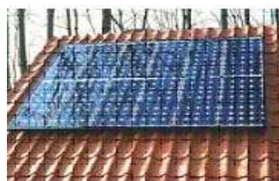
Posés sur la toiture
