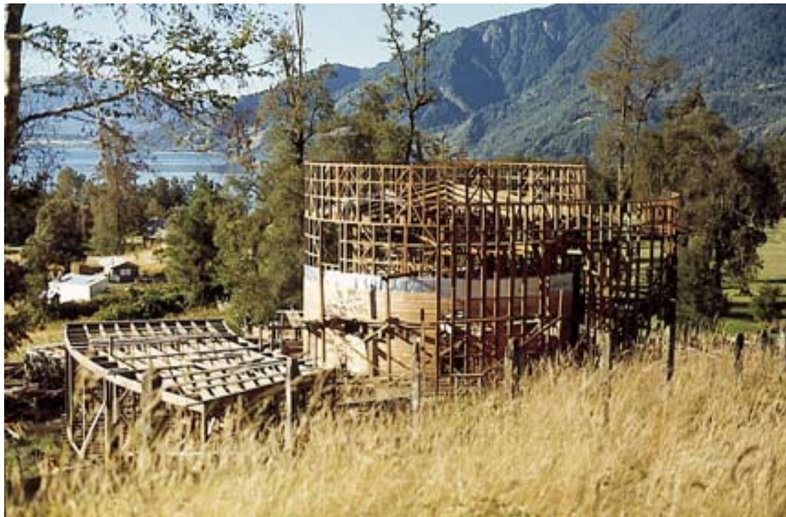
Fotos de obra, heridos y pies derechos de tambor principal. Fotos de obra, y obra gruesa terraza zócalo.
