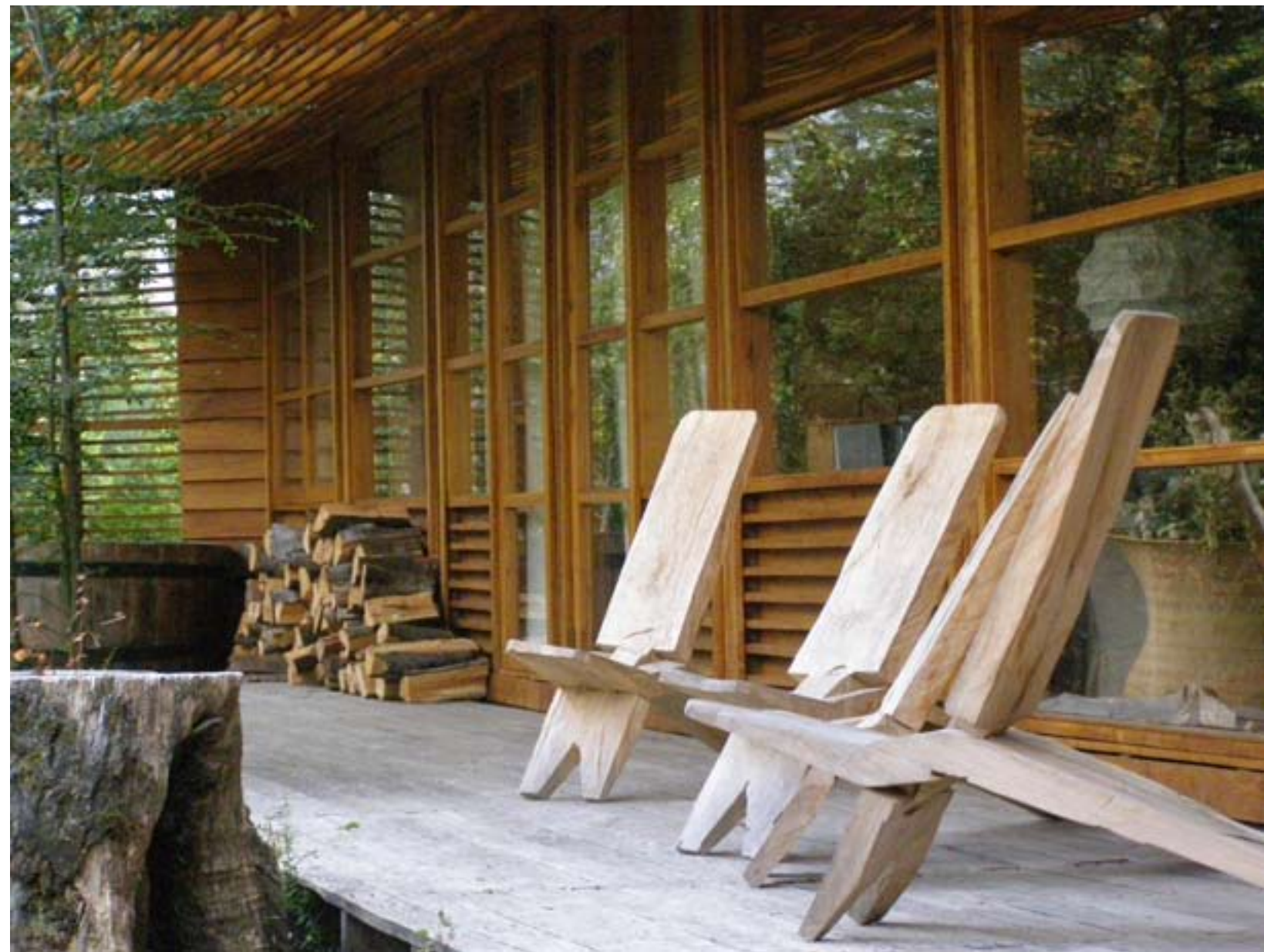
Pág. 88, detalle ventanas, pilar central.
