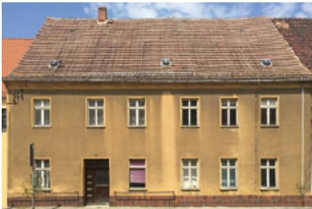
Mehrfamilienhaus, Bj. ca. 1910, Denkmalschutz, Sanierungsgebiet, Massivbauweise, 2-geschossig mit ausbaufähigem DG, Satteldach mit Dachziegeleindeckung. Unsanieretes Gebäude mit Feuchtigkeitsschäden, sämtliche Installationen und Ausstattungen sind veraltet, Ofenheizung. Altinventar und Müllablagerungen vorhanden. Das Objekt befindet sich insgesamt in einem stark sanierungs- und modernisierungsbedürftigen Zustand.
