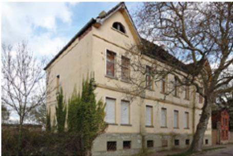
Altbau, Bj. unbekannt, Massivbauweise, 2-geschossig mit nicht ausgebautem DG, Walm-dach mit Ziegeleindeckung tlw. defekt, unterkellert, Holzfenster tlw. defekt, einfache Ausstattung, Setzrisse, Putzabplatzungen, Deckendurchbrüche, Vandalismusschäden, Feuchtigkeitsschäden, Schimmelbefall, gesamtes KG steht unter Wasser, insgesamt stark sanierungs- und renovierungsbedürftiger Zustand.
