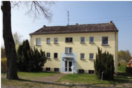
Mehrfamilienhaus, Bj. ca. 1962, Massivbauweise, 2-geschossig mit nicht ausgebautem DG, Satteldach mit Betondachsteinen, unterkellert, Ölzentralheizung, im KG Holzeinfachfenster, im EG und OG Kunststoffisoliertglasfenster mit Außenjalousien. Setzrisse, Putzabplatzungen, Feuchtigkeitsschäden, tlw. Schimmelbildung in den Wohnungen (was vermutlich auf die fehlende Außendämmung zurückzuführen ist), insgesamt stark sanierungs- und renovierungsbedürftiger Zustand.
