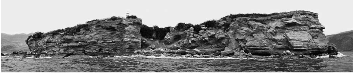
Είκ. 4. Ἡ νότια ὄψη τῆς βραχονησίδας Ἅγιος Δημήτριος. Στὸ μέσον διακρίνεται ἡ τομὴ τῆς τάφρου καὶ τὰ κατάλοιπα τοῦ τοίχου.
