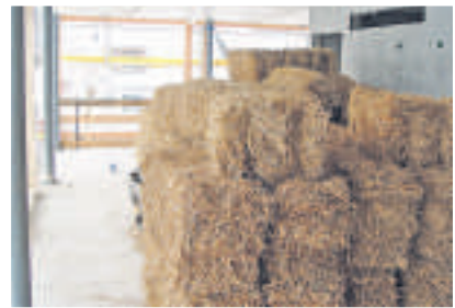
Die Strohballen werden als Ganzes in die Wände eingepasst!
