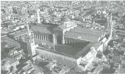
Gran mezquita de los Omeyas (Damasco, Siria). En la construcción de las mezquitas se sigue el modelo de la casa de Mahoma en Medina, que consistía en un gran patio con pórticos abiertos de columnas.
