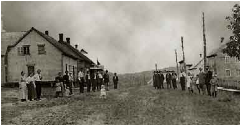
Vue du village après quelques années de vie
