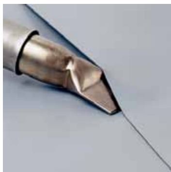
Enkel forarbejdning af Rhepanol hg med varmluftsvejsning.
