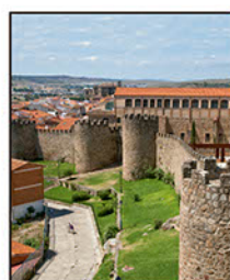
Muralla de Plasencia
