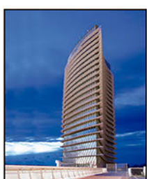
Torre del Agua Expo Zaragoza
