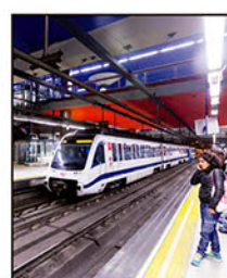
Interior de estación de metro
