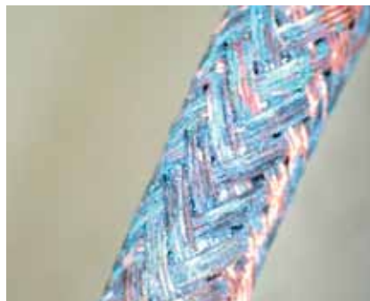
... beginnende Oxidation der Abschirmung einer Leitung (kann sporadische Fehler verursachen)...
