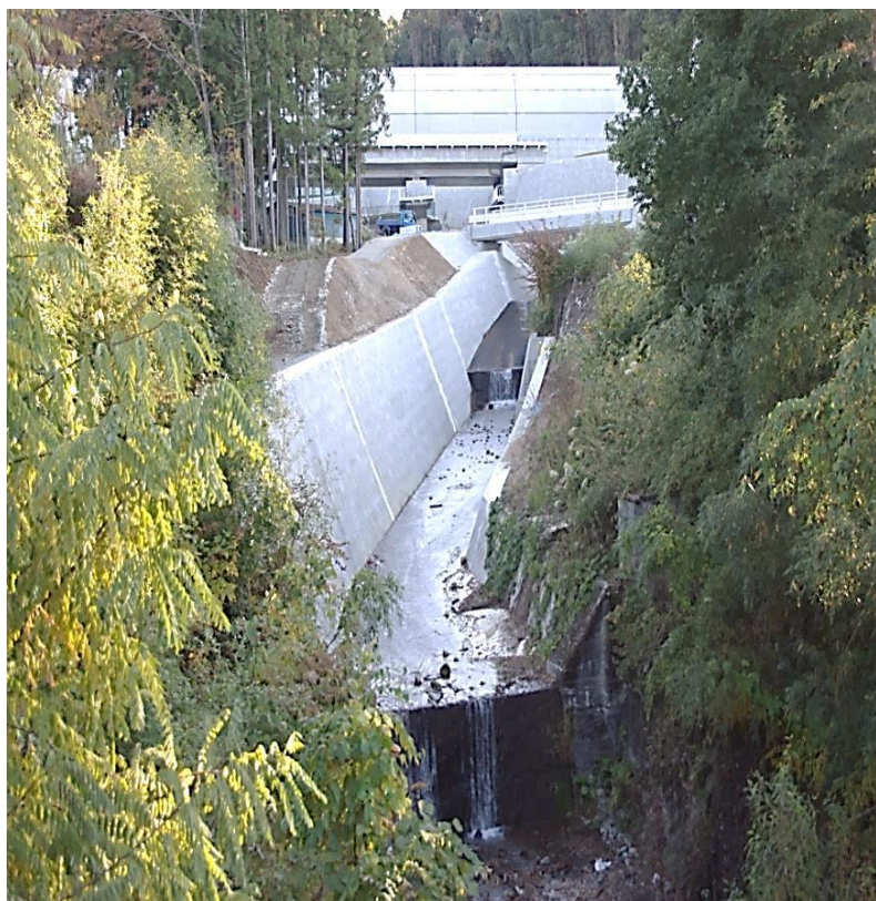
山梨実験線の地下水湧出
