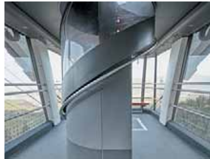
Der Steuerkasten ist in die Wendeltreppe integriert.
