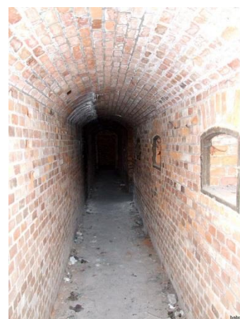
Poterna w filarze południowego przyczółka łącząca obie wieże.
