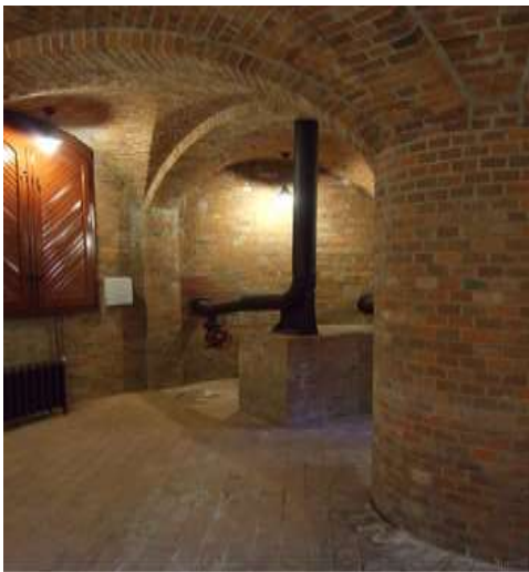
Najniższa kondygnacja wieży
