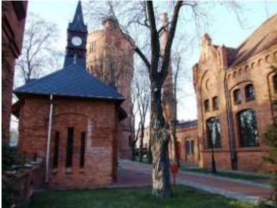
Komora zasuw i Hala maszyn
