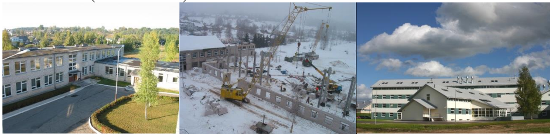
1.-3.attēls Valsts robežsardzes koledžas mācību korpusa rekonstrukcija 29
