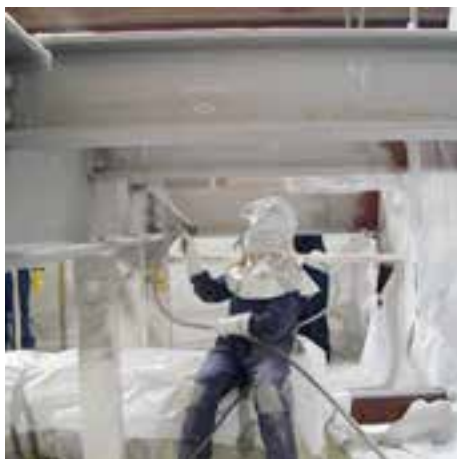
Нанесение ЛКМ безвоздушным методом распыления
