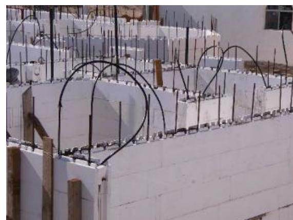
Al interceptarse bloques dalas, se deberá cortar el o los costados de la pieza que obstruya el paso, para hacer un colado integral de forma horizontal.
