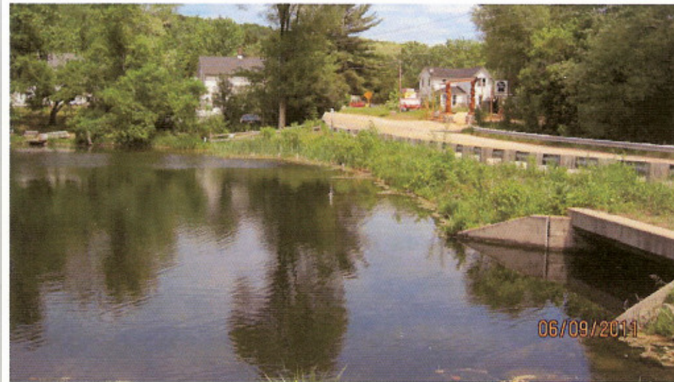
Left U/S Enbankment (0009300609201102)
